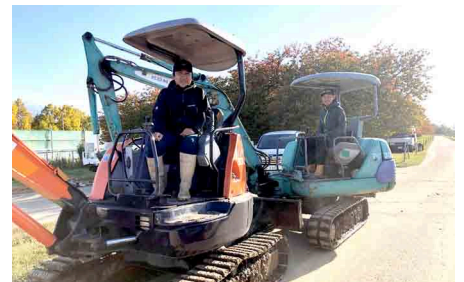
重機部隊は木島平村の米農家のみなさん。町内の外空創作室さんも重機を提供。
